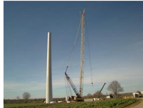
Figure 46 : Montage du mât
