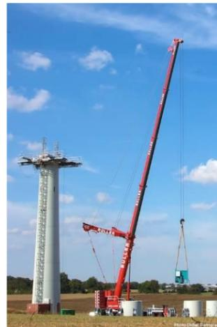
Figure 48 : Montage du mât
