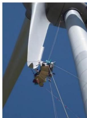
Figure 15 : Installation d'un système de Serration
