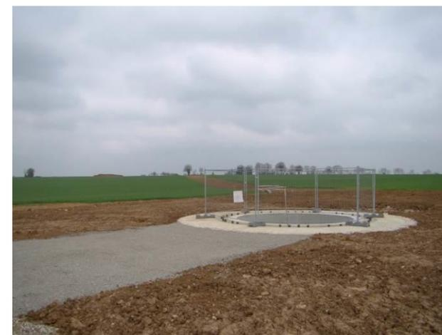
Figure 32 : Remblayage de la fondation terminé
