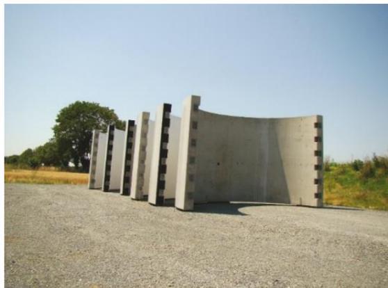
Figure 47 : Zoom sur les différentes sections du mât
