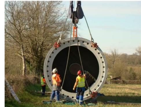
Figure 49 : Deux sections de mâts assemblées
