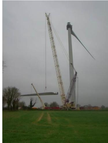
Figure 53 : Assemblage du rotor, pale après pale, directement sur le moyeu
