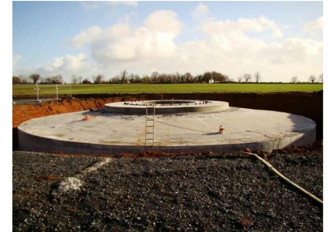
Figure 29 : Coulage du béton
