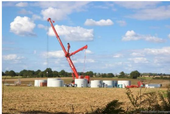
Figure 45 : Différentes sections du mât
