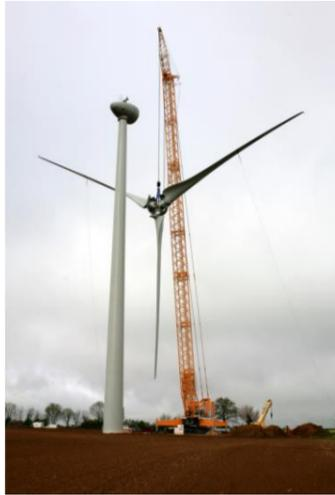
Figure 52 : Assemblage du rotor au sol et hissage
