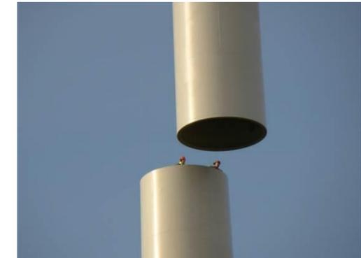
Figure 50 : Assemblage de deux sections de mâts
