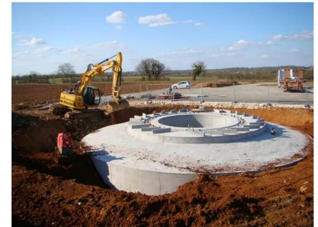
Figure 31 : Remblayage de la fondation
