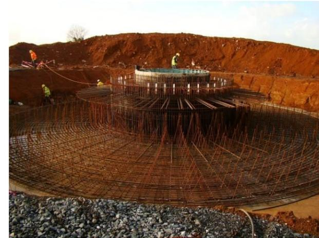
Figure 28 : Exemple de ferraillage en radier pour une éolienne
